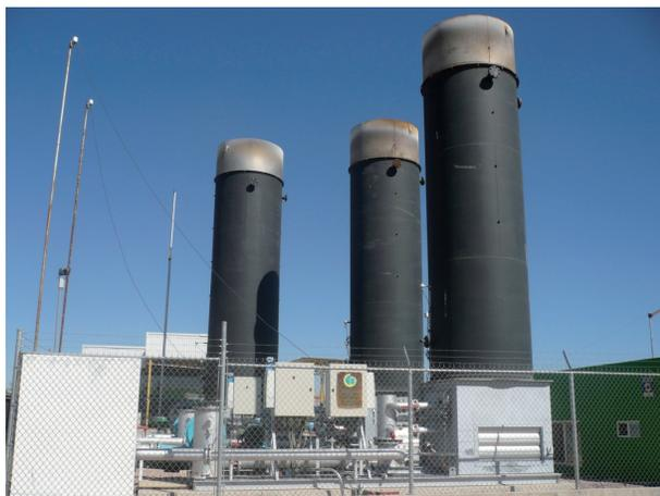
**Fig. 5.** Quemadores para el tratamiento de biogás. Relleno sanitario. Aguascalientes, Aguascalientes
